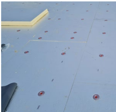
Realizácia kotvenia indukčného kotvenia Isoweld®
