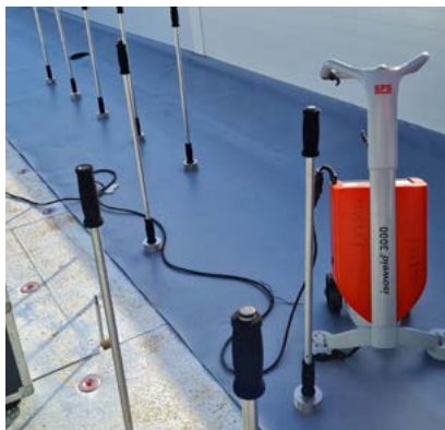
Isoweld® - systém indukčného kotvenia pre ploché strechy
