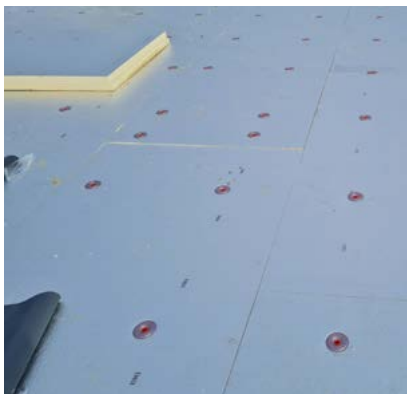
Realizácia kotvenia indukčného kotvenia Isoweld®
