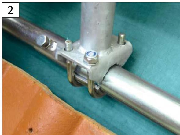
2 Polohu voliť tak, aby nosná tyč držiaka (4) prechádzala zvislo cez nadstavec DuroVent pre anténu a satelit. Montážnu hlavu s maticami (5) a zvislú tyč držiaka (4) upevniť tak, aby bol
