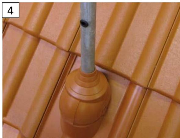
4 Nadstavec DuroVent pre anténu a satelit (6) odrezat' na potrebný priemer 43 mm, nasunúť na zvislú tyč a upevniť na prestupovú škridlu Durovent.
