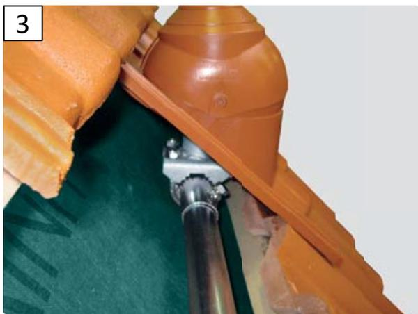
3 Vymedzenie správnej polohy držiaka umožňuje plynulý prechod tyče cez nadstavec DuroVent.
