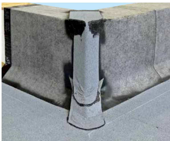
7d, APLIKÁCIA VRCHNÉHO PÁSU S POSYPOM
