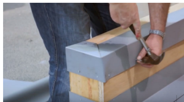
Tvarovanie profilov a ich mechanické prichytenie k podkladu.
