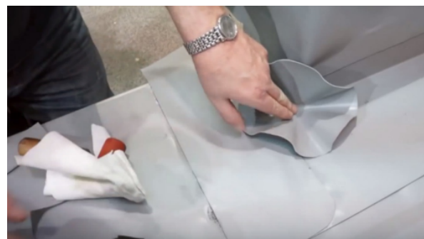
Po zaizolovaní atiky sa uložia tvarovky na požadované miesto.
