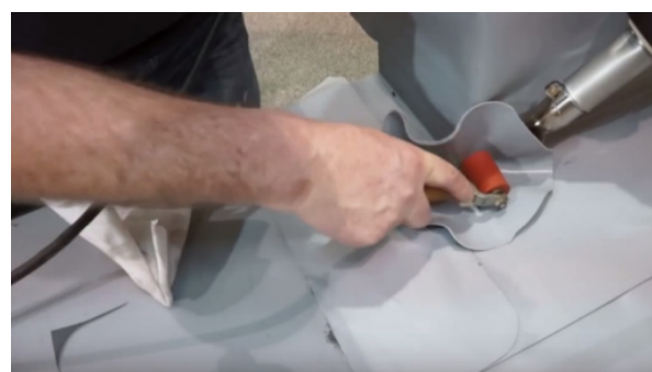
Privarenie tvarovky v strede a na jej hranách, resp. v kútoch.
